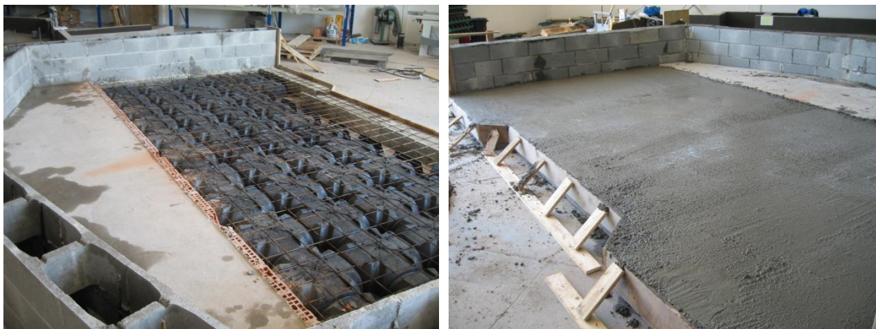
Figura B.6 – Posizionamento degli “igloo” e gettata finale.
